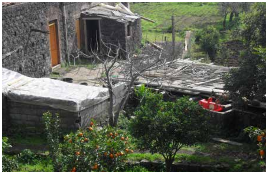
Il pozzo cisterna ripristinato grazie all'aiuto della Fondazione
